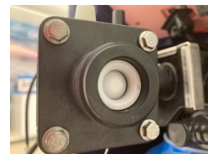
Bride de raccordement de la tête de l'adoucisseur (ENTRÉE/SORTIE)
