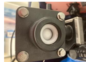
Bevestigingsbeugel van de kop van de waterontharder (INLAAT/UITLAAT)
