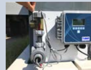
Koeltoren Basisregelaar – voor de automatische spui
