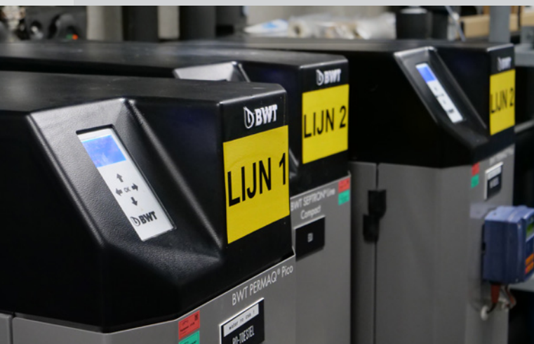
2-traps omgekeerde osmose voor de CSA (centrale sterilisatieafdeling)
